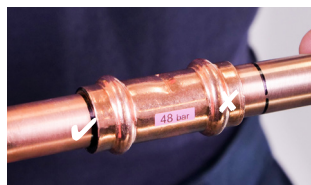
10. Rohr in den Fitting einführen
