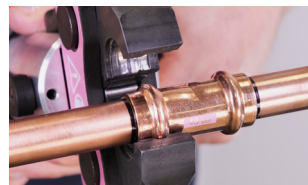
11. Pressbacke rechtwinklig ansetzen
